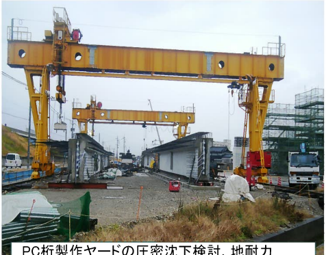
PC桁製作ヤードの圧密沈下検討、地耐力検討等の仮設設計
