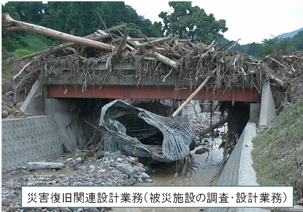
土砂災害や流木災害で倒壊した施設の施設復旧設計を行っています
