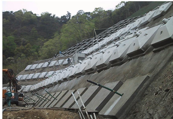
大型アンカーを用いて斜面对策を行った例 (地中にグラウトによって造成する定着部と地表部の構造物を、高強度の引張材で連結させ、引張力を利用して不安定斜面を安定させる工法です)
