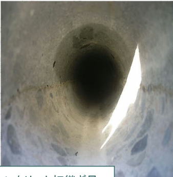
BB生コンを用いた谷止工等の漏水対策(コンクリート打継ぎ目からの漏水調査を行い、原因追求から対策工法の提案検討)
