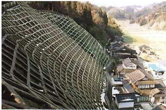
斜面の安定解析を行い斜面对策工の比較検討、対策工の実施設計を行っています。 (フリーフレーム工法の例)
