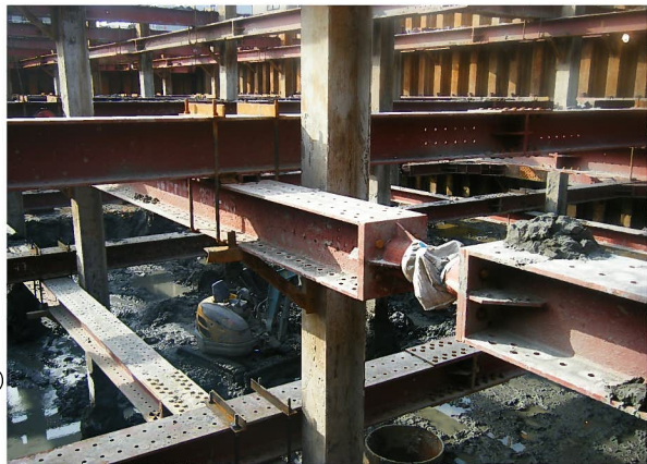
中間杭(杭先端部はモルタル注入) と切梁、腹起しの設置状況
